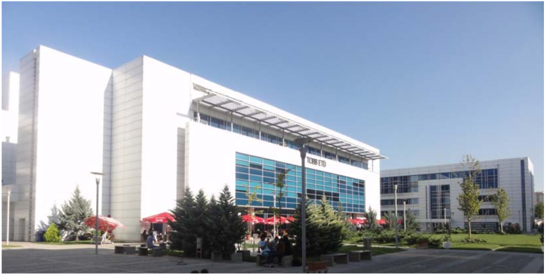
Şekil 5.1 Ana Bina Fotoğrafi (I. Bina)
