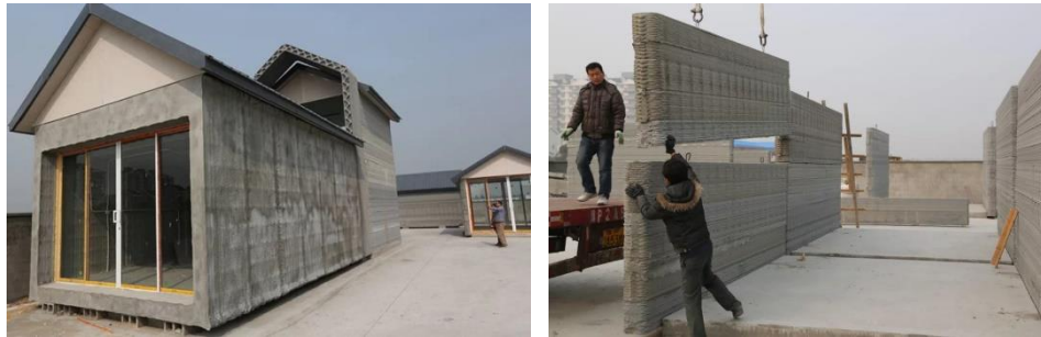
Figür 2.7. Winsun Evleri ve Yerinde Montaj Aşaması (Caula, 2014)
