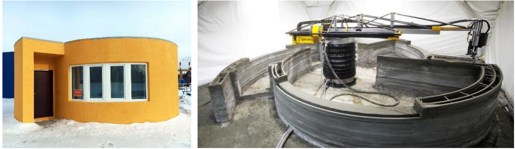
Figür 2.12. Mobil 3 Boyutlu Yazıcı İle Yerinde Üretilen İlk Konut Evi (Garfield, 2017)
