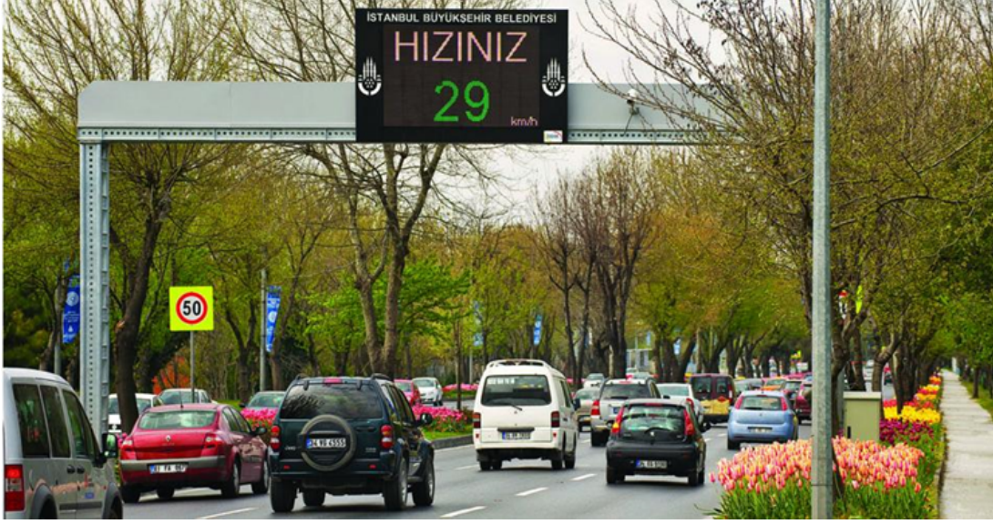
Resim 3.1: Led ekranlı trafik bilgi paneli.
