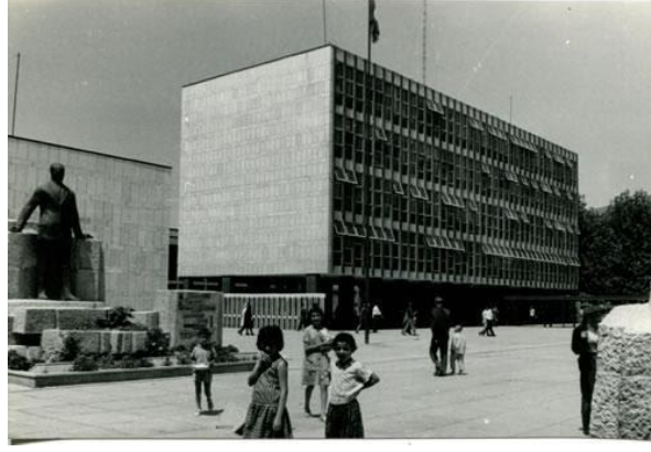
Figure 5.6 : Sakarya Hükümet Konağı, Sakarya, 1956. 13
